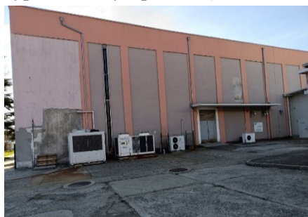
Сграда производствена част и хладилна камера Инв.№ 2030-0000607; 2040-0011789 (идентификатор 67338.536.12.1)
